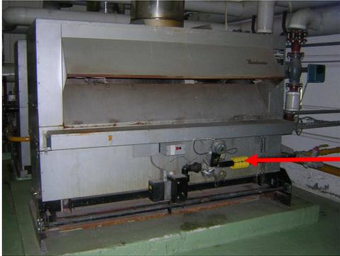
Beispiel : die Spargeräte wurden möglichst nah an dem Verbrennungsort auf die Gasleitung installiert
